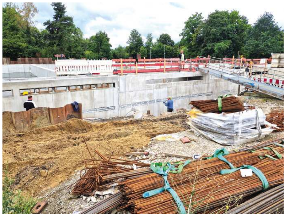
Betonarbeiten Belebungsbecken 3
